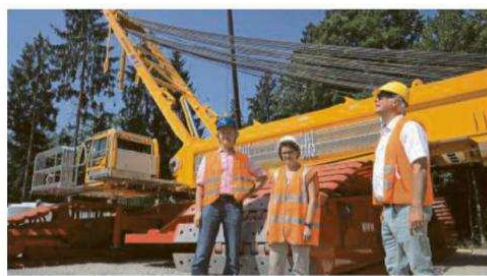
Die Raupe und die Einzelteile des 160-Meter-Krans stehen bereit für die Anlagenmontage. Sie soll noch in dieser Woche erfolgen.
